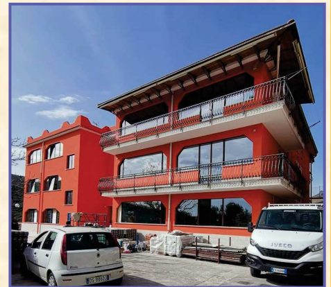
Efficientamento energetico condominio—Monreale
