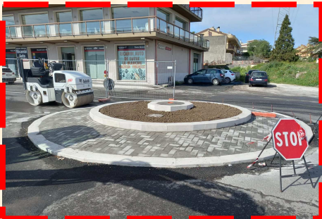
Via di fuga lato Nord—Lentini
